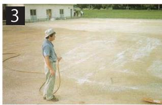
3 ホース等を使用し散水します。翌日ローラーで土を締め固めます。
